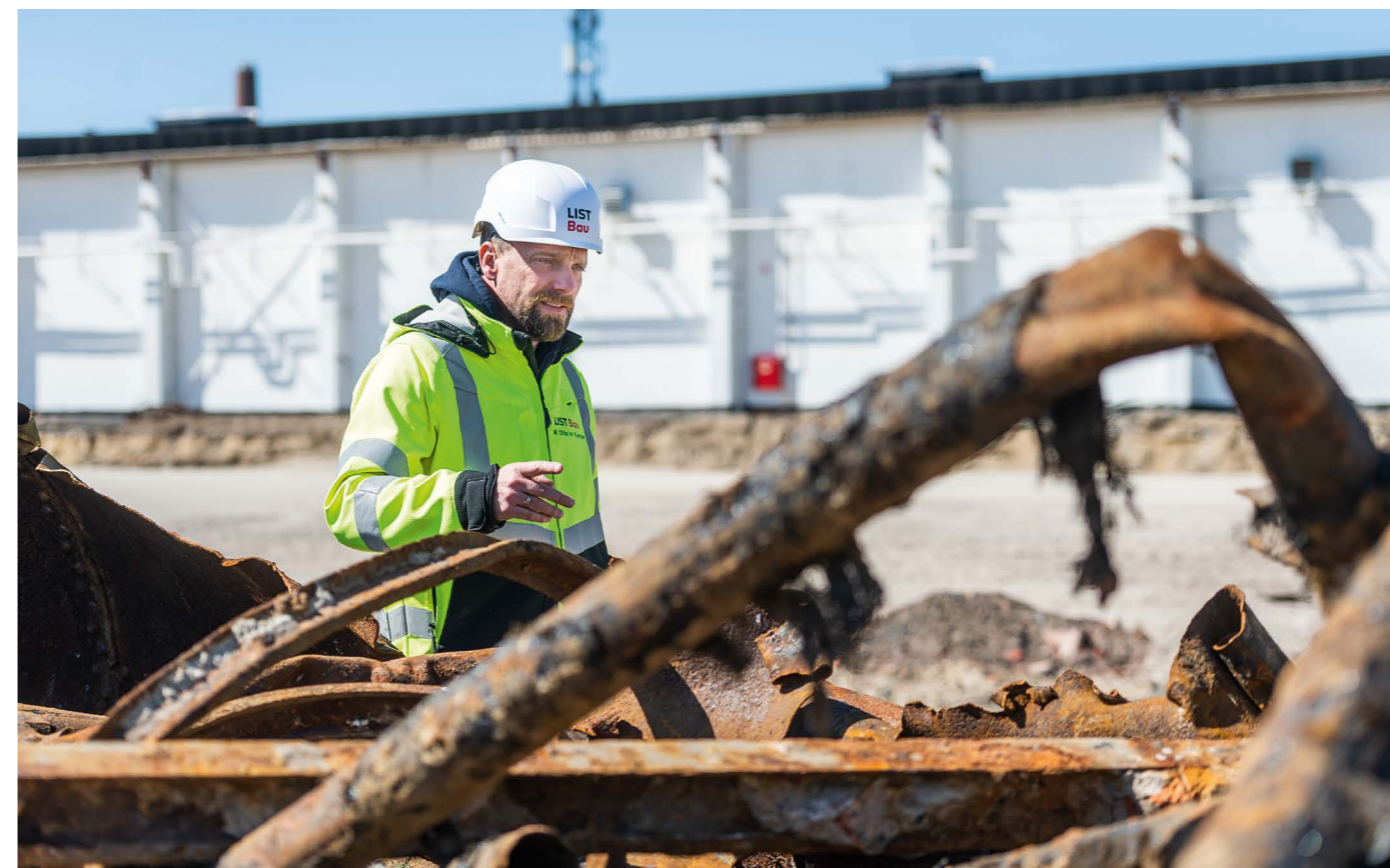
Unten: Verborgene Schätze aus dem Untergrund: Das Erdreich musste von zahlreichen Funden wie Schmelzriegeln, Gleisen, Rohren und mehr befreit werden.
