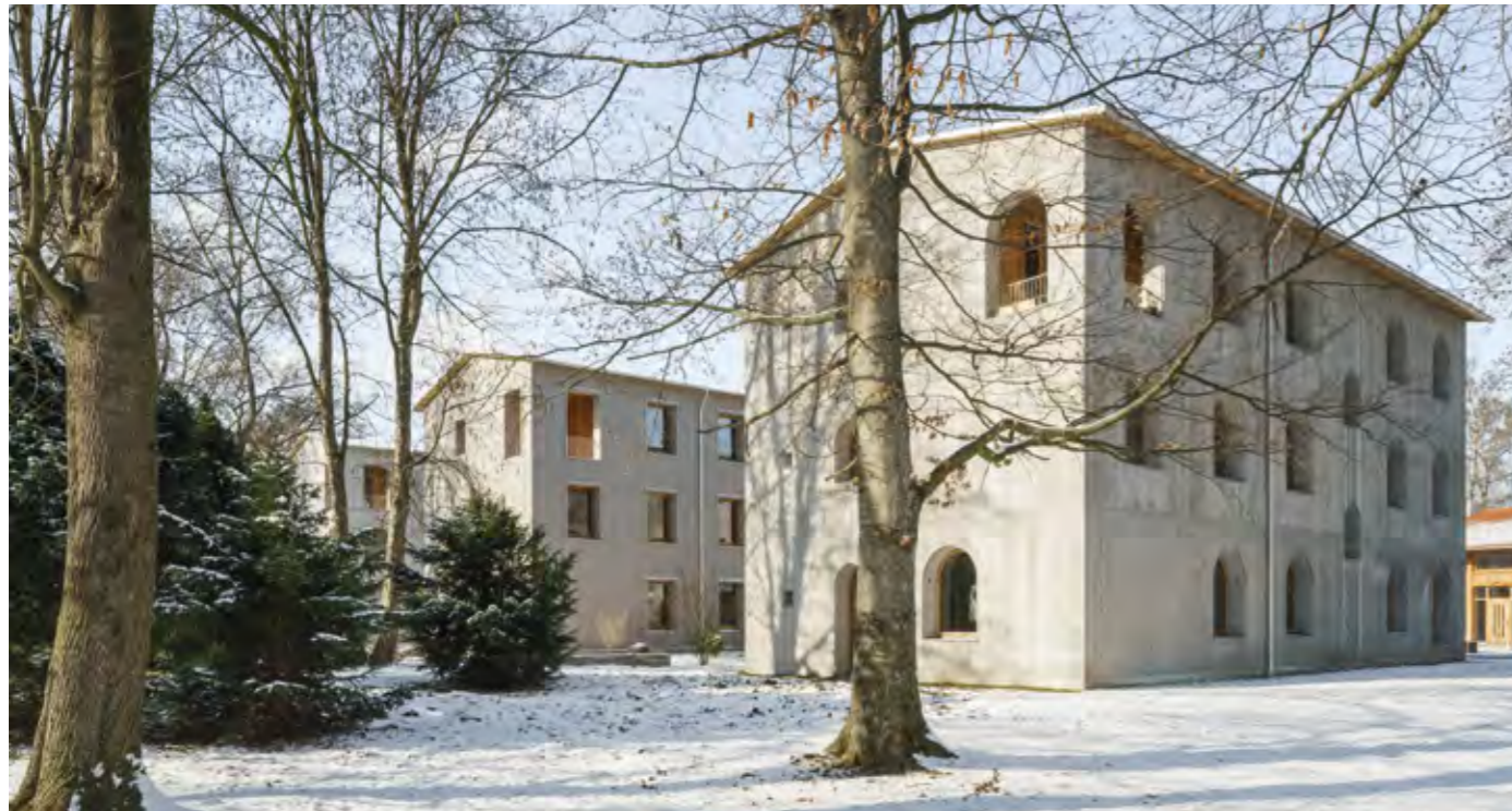
Die drei Forschungshäuser „Einfach Bauen“ wurden aus Massivholz, Mauerwerk und Leichtbeton in monolithischer Bauweise von Florian Nagler in Bad Aibling errichtet. Ihr Energieverbrauch wird im Betrieb gemessen.
