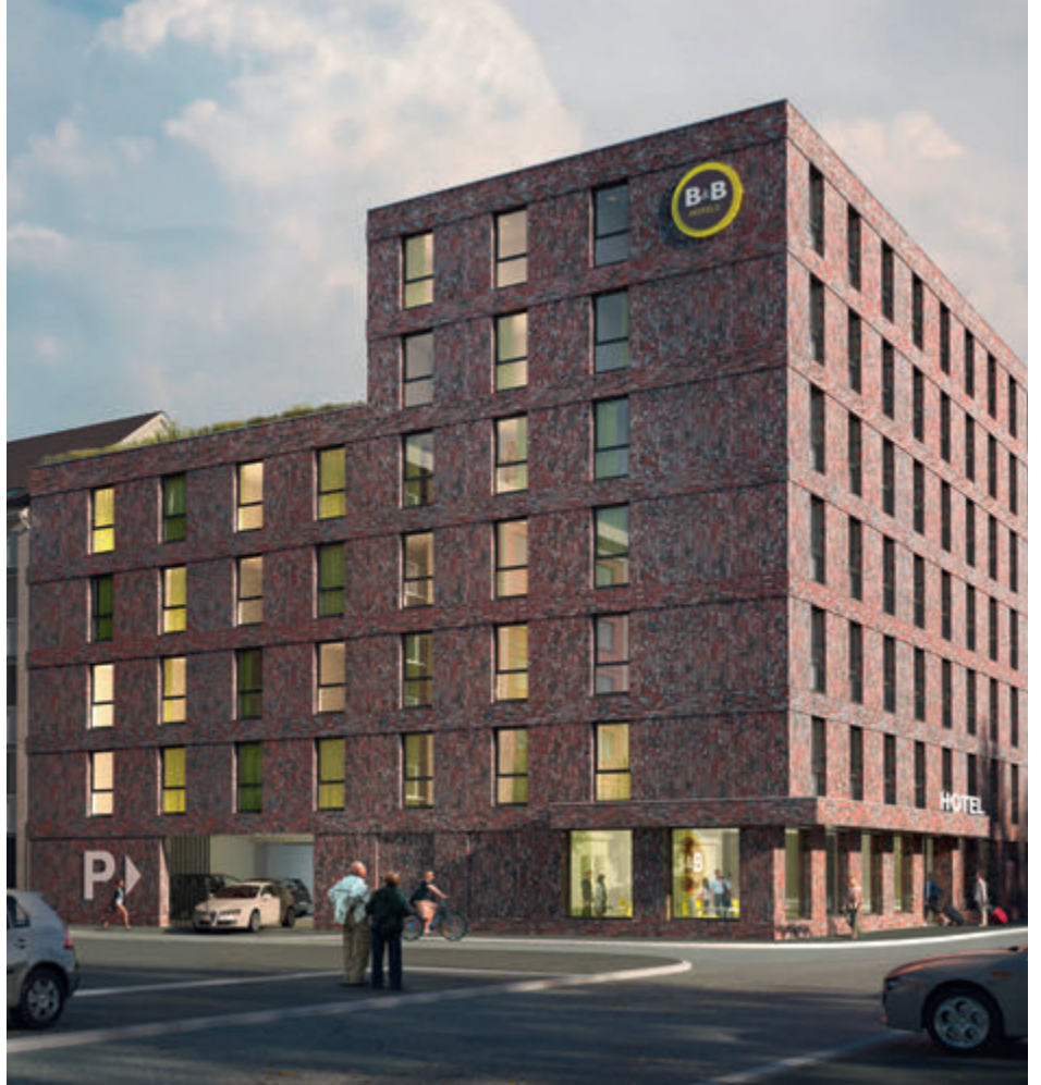
Hier in Dortmund entsteht eines der fünf B&B Hotels, deren Bau Heinz und Sven zurzeit gemeinsam koordinieren.
